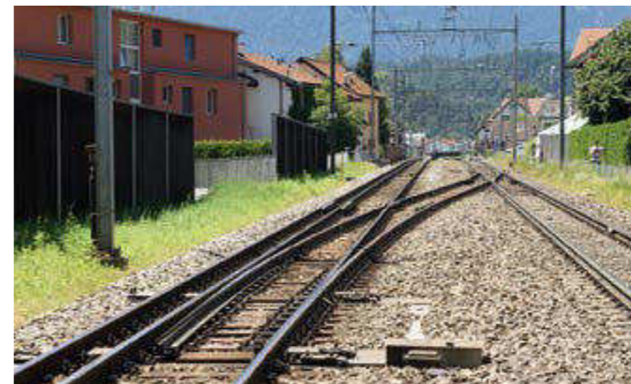
Die Bahnhofseinfahrt von Domat/Ems aus Chur mit dem Schmalspurabzweig zum zweiten RhB Streckengleis.
